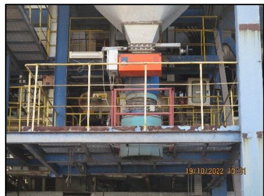
ภาพที่ 2.28 ไซโลรวบรวมเถ้าหนัก (Bottom Ash) ภายในโครงการ
