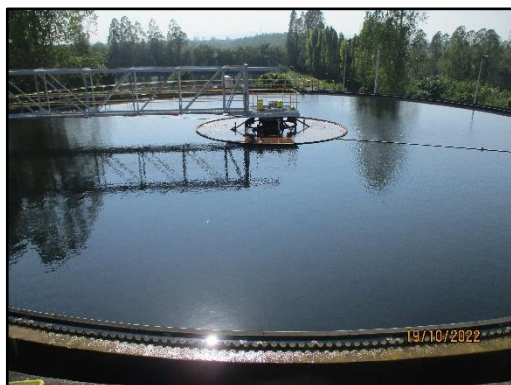
ภาพที่ 2.9 ระบบบำบัดน้ำเสียแบบเอเอส (Activated Sludge)
