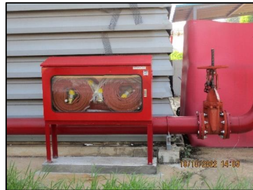
ภาพที่ 2.42 ท่อน้ำดับเพลิงและหัวจ่ายน้ำดับเพลิง ภายในโครงการ
