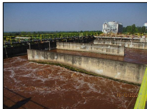
ภาพที่ 2.9 ระบบบำบัดน้ำเสียแบบเอเอส (Activated Sludge)
