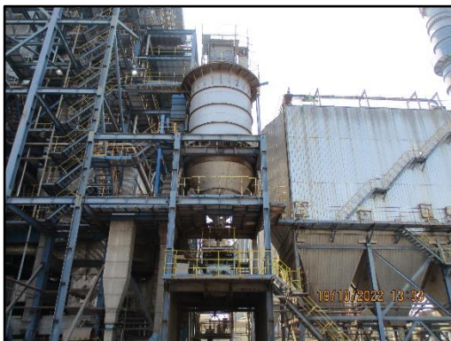
ภาพที่ 2.4 ไซโลรวบรวมเถ้าเบา (Fly Ash) ภายในโครงการ
