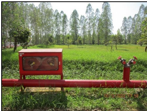
ภาพที่ 2.42 ท่อน้ำดับเพลิงและหัวจ่ายน้ำดับเพลิง ภายในโครงการ
