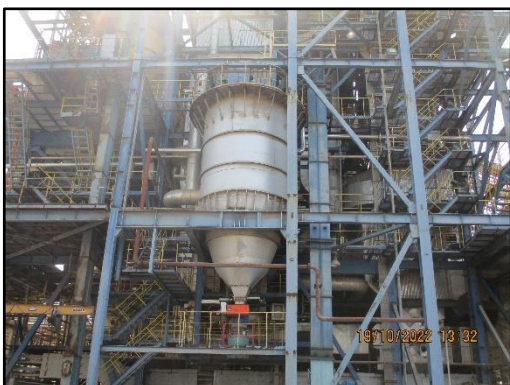
ภาพที่ 2.28 ไซโลรวบรวมเถ้าหนัก (Bottom Ash) ภายในโครงการ
